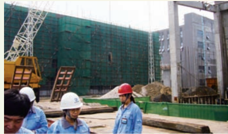
▲ 草桥燃气联合循环热电厂二期工程项目施工现场
